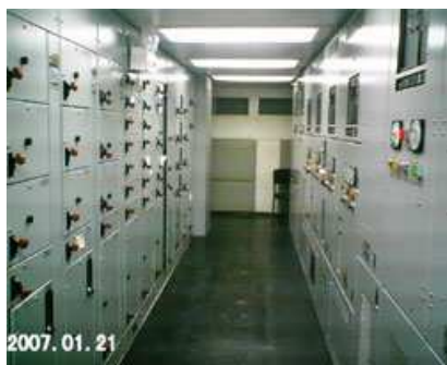
شکل 28 :SCR Unit
