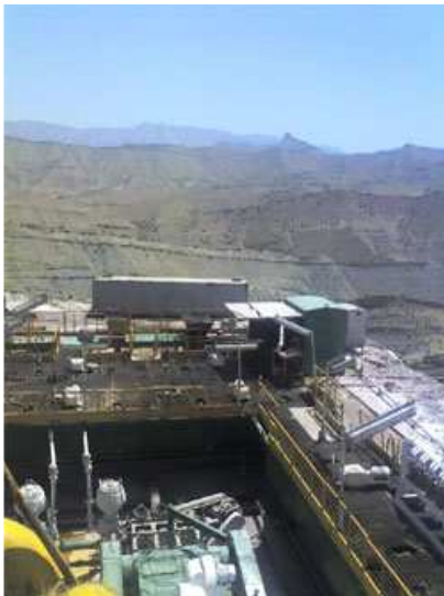
شکل 39 : Mud Tanks
